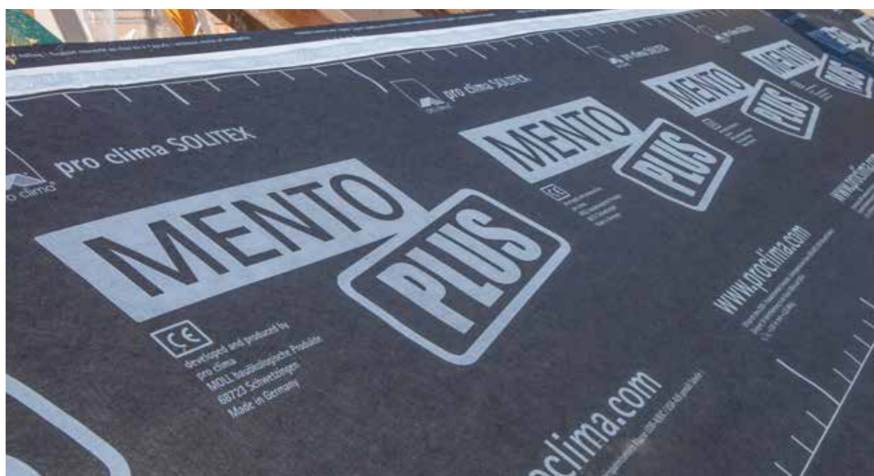
Les écrans de sous-toiture de la gamme SOLITEX MENTO sont extrêmement résistants au vieillissement, étanches et perméables à la vapeur d'eau : le film fonctionnel monolithique SOLITEX protège parfaitement l'isolation de l'extérieur.
