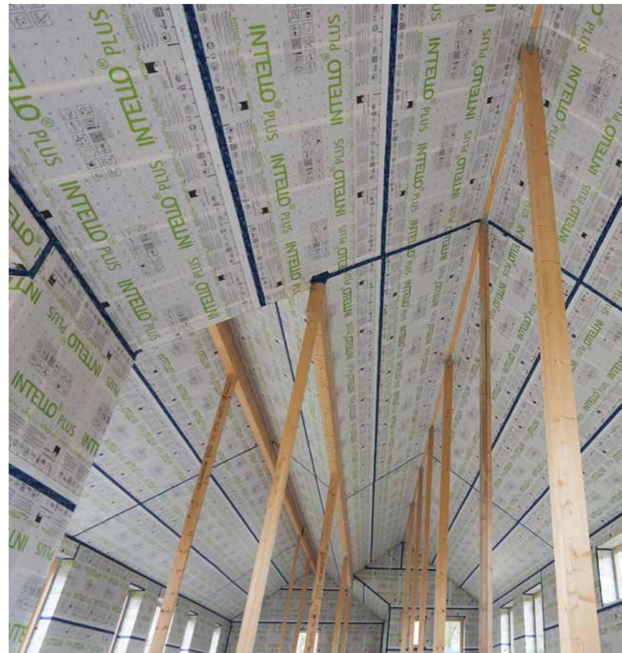
Avec la membrane INTELLIO hygrovariable, pro clima a posé de nouveaux jalons en matière de protection contre les dégâts du bâtiment et les moisissures.
