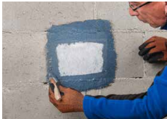
AEROSANA FLEECE Dichtet Löcher bis max. 70 mm Durchmesser und Anschlüsse (z. B. bei der Dachsanierung von außen) im AEROSANA VISCONN -System.
