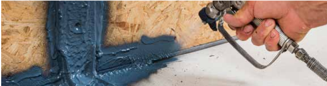
AEROFIXX Auftragswerkzeug für Schlauchbeutel im AEROSANA-System
