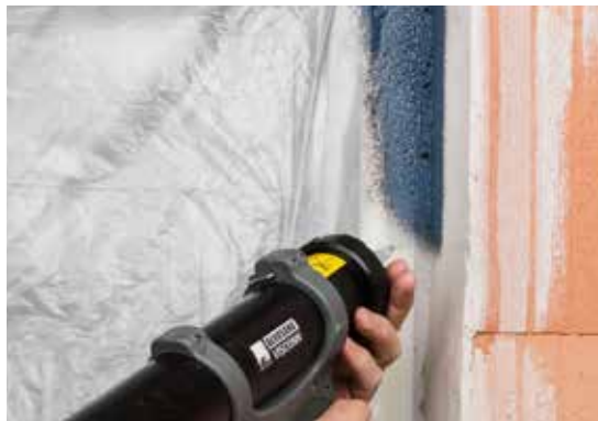
AEROFIXX Auftragswerkzeug für Schlauchbeutel im AEROSANA-System
