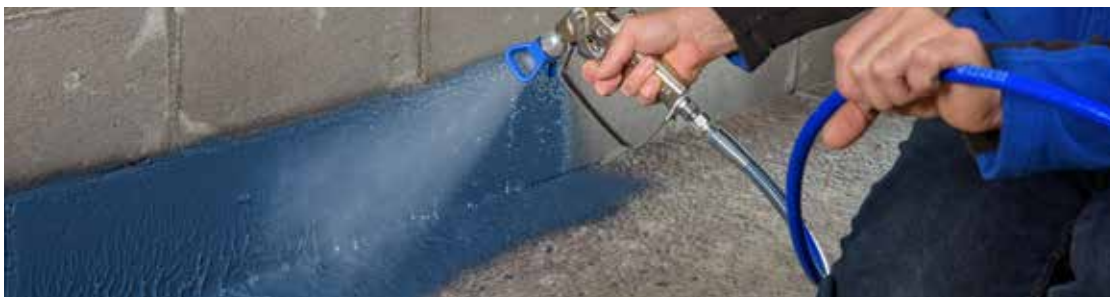
AEROSANA VISCONN Sprüh-/Streichbare Luftdichtung für zügiges Dichten von Flächen und Anschlüssen, blau/schwarz
